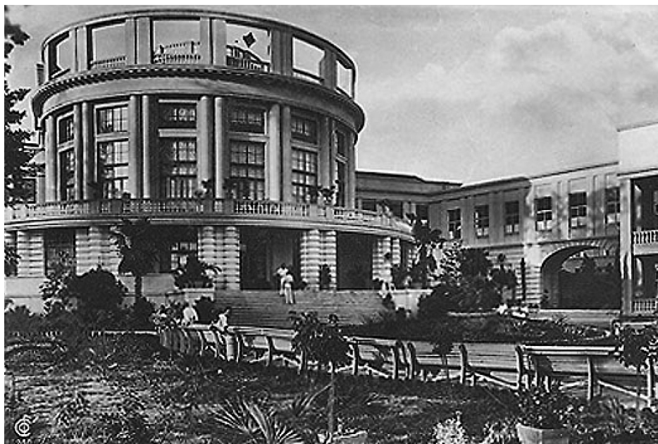
Вид с аванплощади на здание столовой санатория
