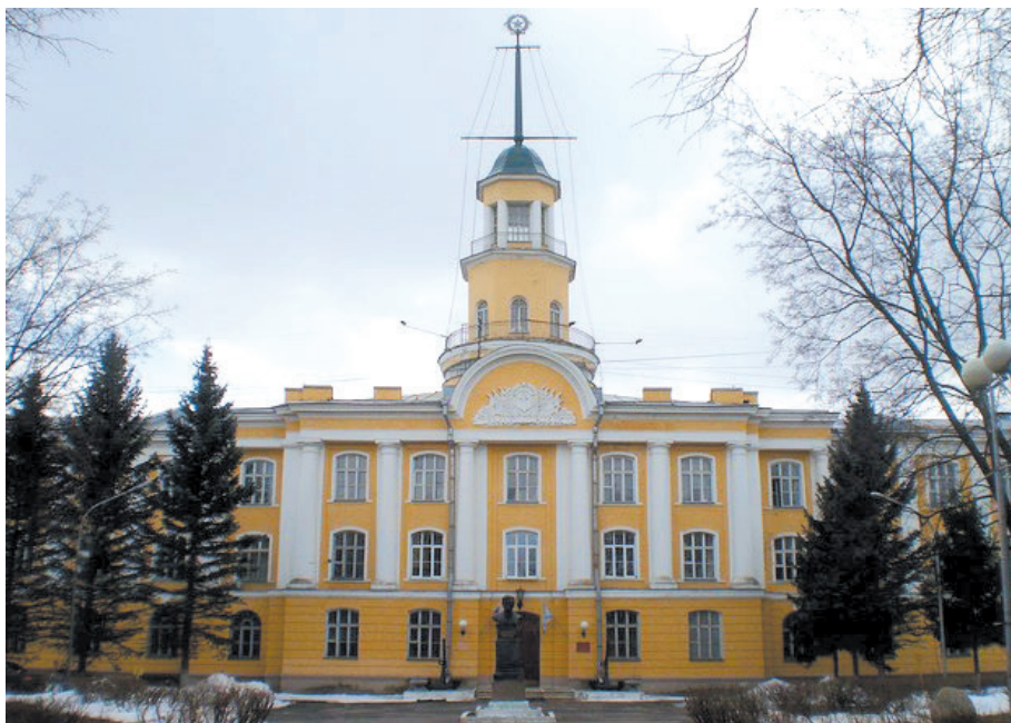
Башня учебно-административного корпуса. Вид с Санкт-Петербургского пр.
