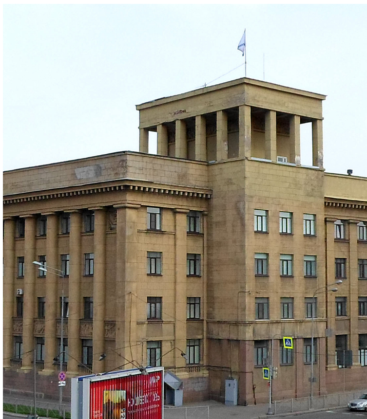
Угловой элемент на здании специальных офицерских курсов Военно-морского флота
