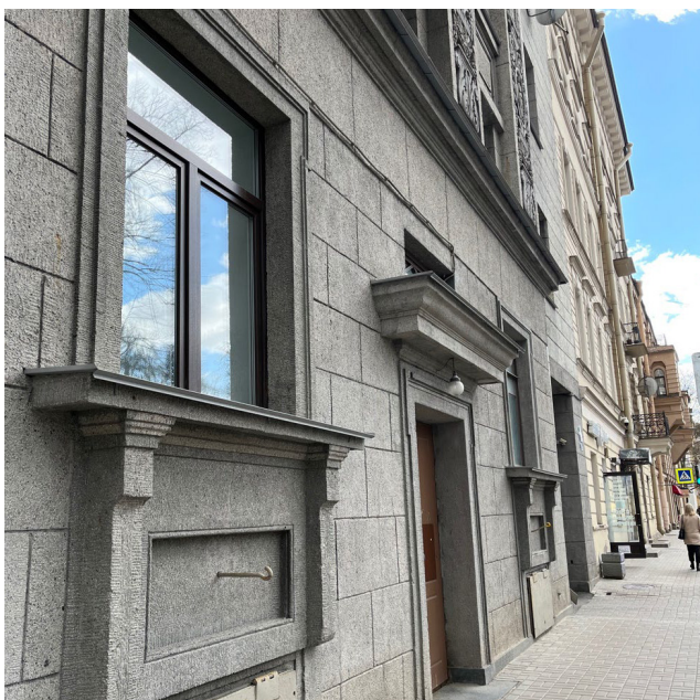
Фрагмент фасада. Портал входа
