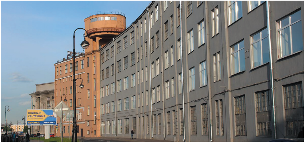
Корпуса завода им. Козицкого
