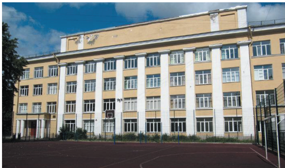
Школа. Курляндская ул., 43
