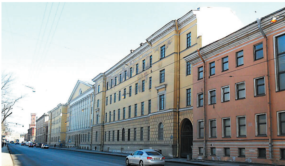
Здание Военно-морского госпиталя на Старо-Петергофском пр. Вид в сторону р. Фонтанки
