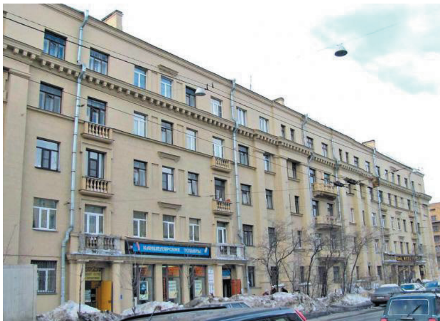
Здание общежития Гидрографического института. Вид со стороны ул. Стахановцев
