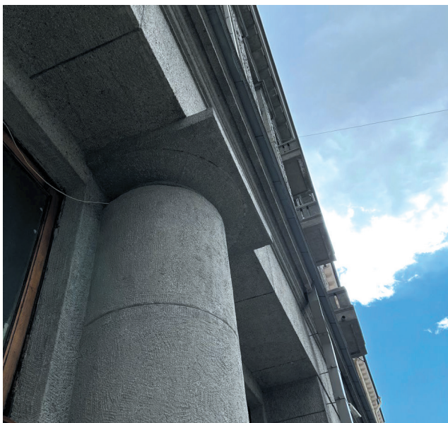
Таврическая ул., 31–33. Колонна 1-го этажа
