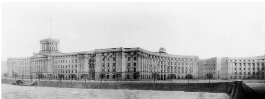
Здание Минно-торпедного и артиллерийского института. Окончательный вариант. Перспектива со стороны Малой Невки. 1941–1945 гг.
